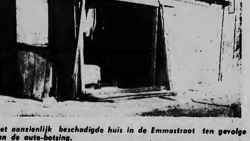
Het aanzienlijk beschadigde huis in de Emmastraat ten gevolge van de auto-botsing.
